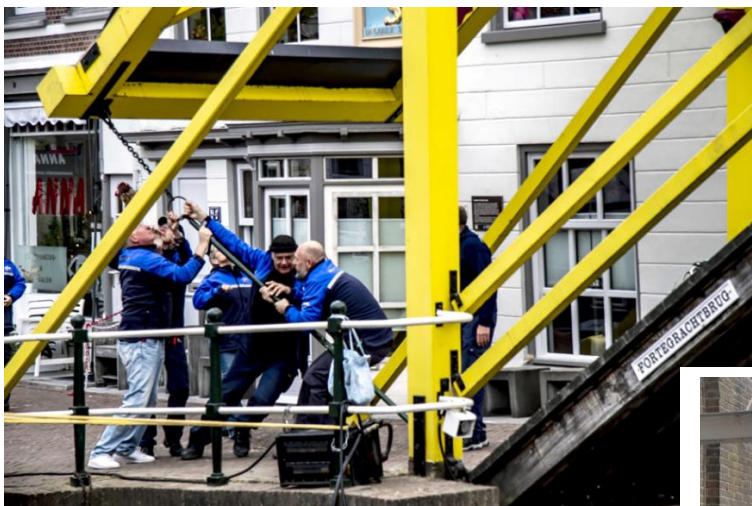
Ponton van de sluis in de sluis voor onderhoud en schoonmaakwerkzaamheden
